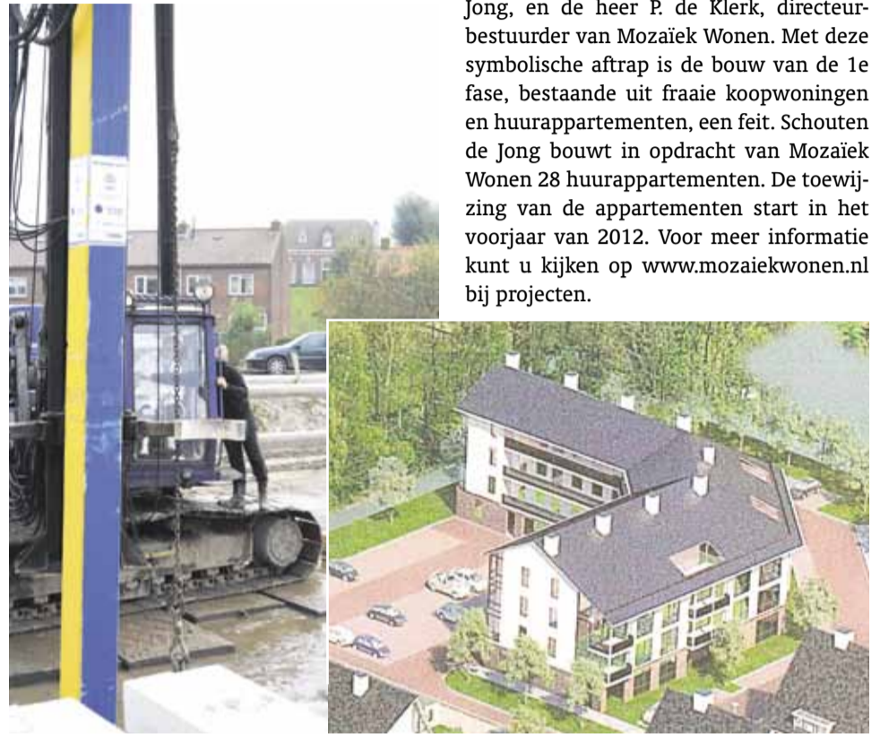
Eerste paal is geslagen bij bouw Prinsessenkwartier in Moordrecht.
